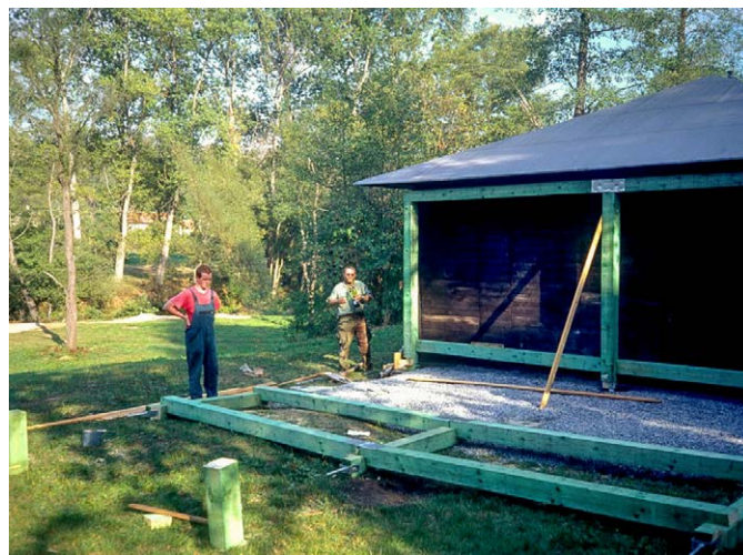
Přístavba dřevníku, září 2003
