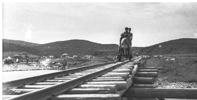
Stavba hrází, 1938, autor R. Reimer
