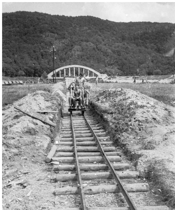
Stavba hrází, 1938, autor R. Reimer
