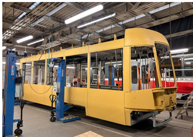
Vůz, který ponese evidenční číslo 1863 je z větší části nalakovaný a pokračuje instalace kabeláže
