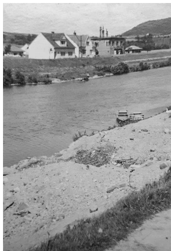
Stavba hrází, autor neznámý
