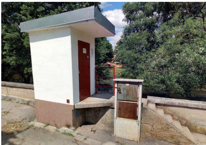
Stávající vodoměrná stanice na pravém břehu Svatky v ulici Nábřeží
