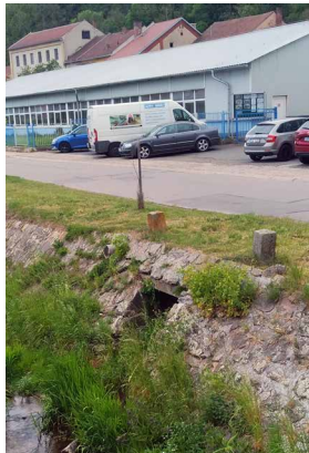
Vyústění jalového náhonu
