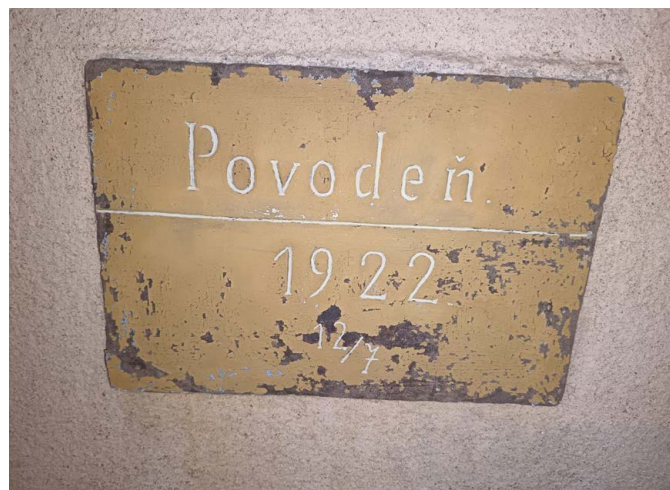
Povodeň připomíná tabulka umístěná na zdi hospodářského stavení v obci Lubě. Foto Nikola Sekaninová
