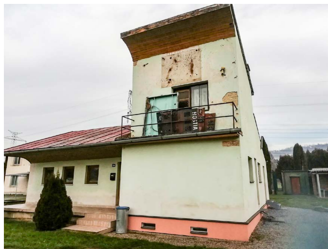
Kabiny před začátkem oprav, 2023
