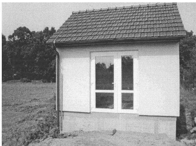
Čerpací stanice v ulici U Hřiště
